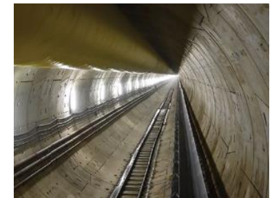
Túnel Emisor Oriente
